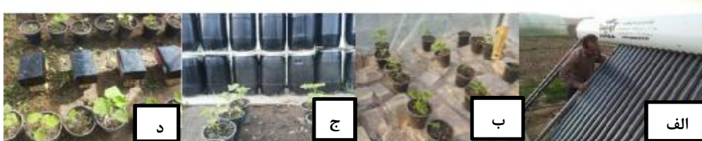
شکل ۲- سامانه ذخیره انرژی خورشیدی. از راست: الف) آبگرمکن خورشیدی، ب) بستر سنگی، ج) دیوار آبی، د) مواد تغییر فاز دهنده
