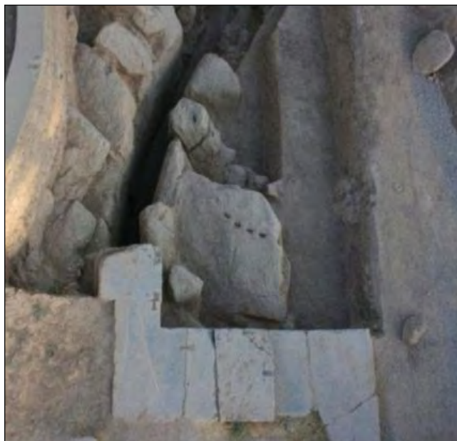
شکل ۷- ردیف سوراخ‌های بازمانده در صخره‌های محل خروجی آبراه‌ها
