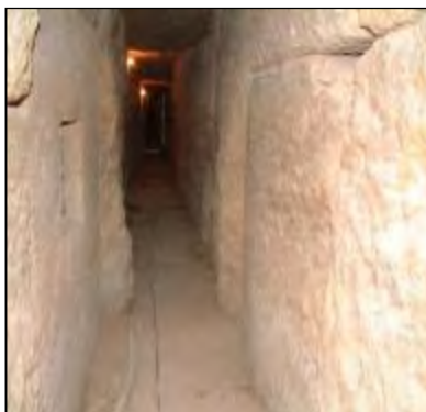
شکل ۲- نمایی از فضای داخلی آبراهه‌ها در بخش خاوری بنای خزانه
